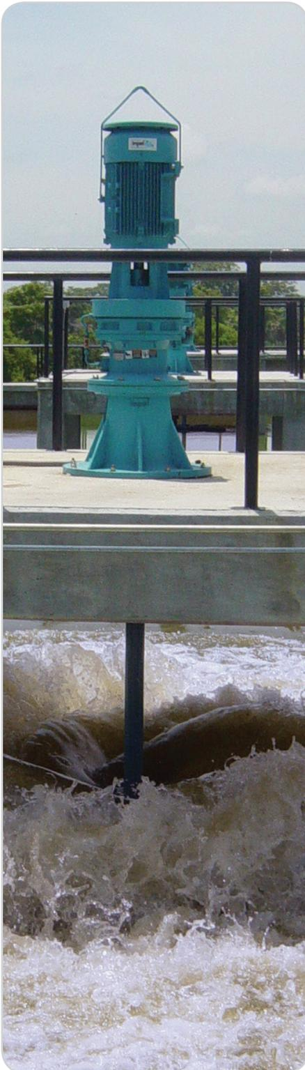
El diseño del impulsor crea tal turbulencia que permite mezclar aire con las aguas residuales donde es disuelto y descargado radialmente a través de la superficie del tanque, lo que permite el mezclado y aereado en una continua acción circulatoria.
