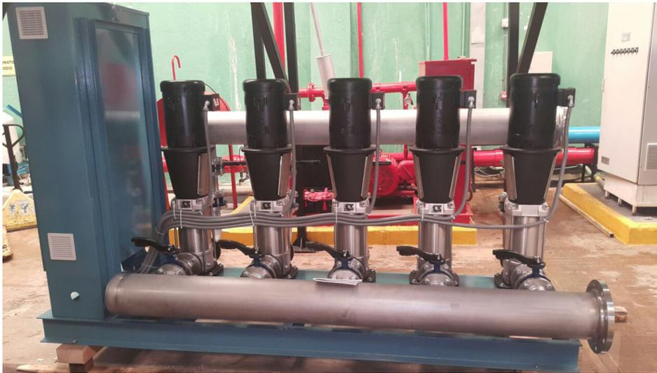
Grupos de bombeo prefabricados de PRESIÓN CONSTANTE para abastecimiento de agua en edificios habitacionales, hoteleros o de oficinas, montados sobre bases comunes estructurales, con bombas verticales de alta o media presión operadas por tableros integrados en el paquete con variadores de frecuencia.
